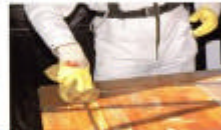
Nachverlebung mit Schwamm und klarem Wasser
