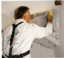
An der Decke: Pulver-Lehrkühl trägt den CKW-freien Abbeizer auf
