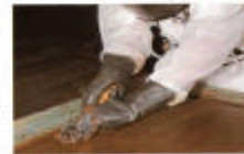
Bei Entfernung der Farbe schlecht zu reiben, nur kratzen
